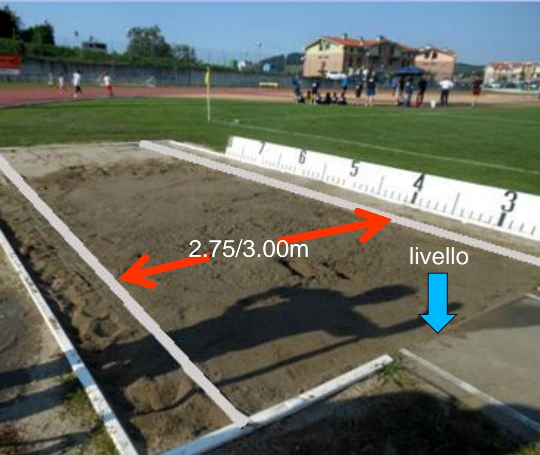
*Quando l'asse della pedana di rincorsa non coincide con la linea mediana della zona di caduta, è necessario fissare un nastro o due per realizzare quanto previsto.*
